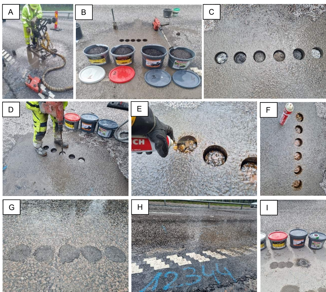
Figur 10. Borning och lagning av borrhål på E20 Hova. A) Borring, B) Förberedelse av utrustning och kallmassa, C) Förberedelse av borrhål, D) Förstämning av underbyggnad, E) Sprayning av kanterna med klister, F) Borrhål förberedda för lagning, G) Färdiglagat borrhål, H) Märkning av lagningar på vägren, I) Avslutad jobb. Bilder: Patryk Witkiewicz.
