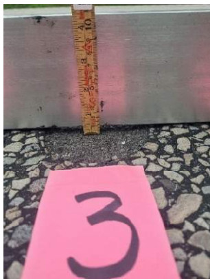
Figur 11. Mätning av lagningens nedsjunkning med tumstock. Bild: Patryk Witkiewicz.
